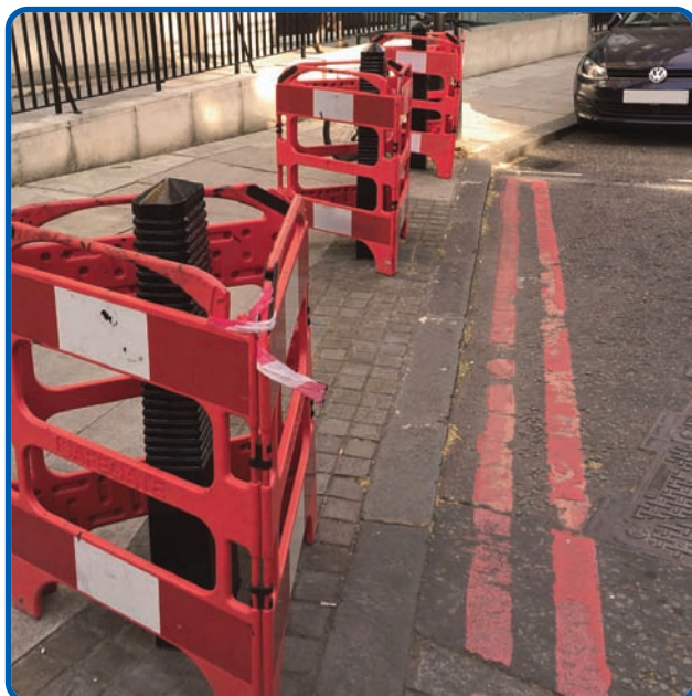
Particolare dell'elemento di blocco e congiunzione lati ●
